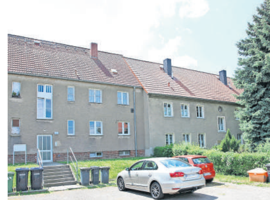
Die SWG will ihre Häuser in der Südstraße 45-55 ab Sommer 2023 sanieren. FOTO: MARIO JAHN
