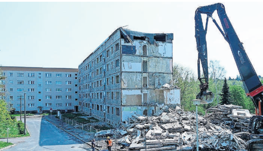
Der lange leerstehende Plattenbau in der Albert-Levy-Straße 26-29 in Altenburg-Nord verschwindet seit dieser Woche.
