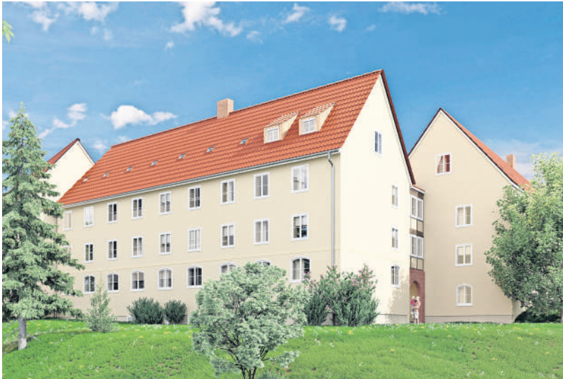
So sehen die Häuser der früheren Gagfah-Siedlung in der Altenburger Käthe-Kollwitz-Straße aus, wenn sie fertig saniert sind.
