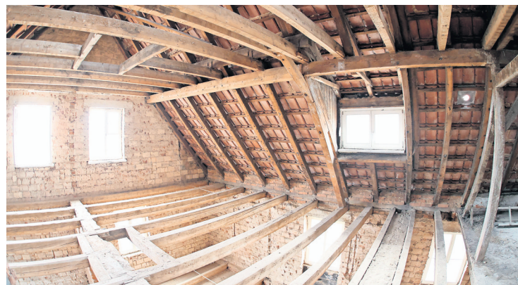
Selbst die Decken werden komplett frei gelegt, um das Holz auf Schädlingsbefall zu prüfen und gegebenenfalls auszutauschen. FOTO: M. JAHN
