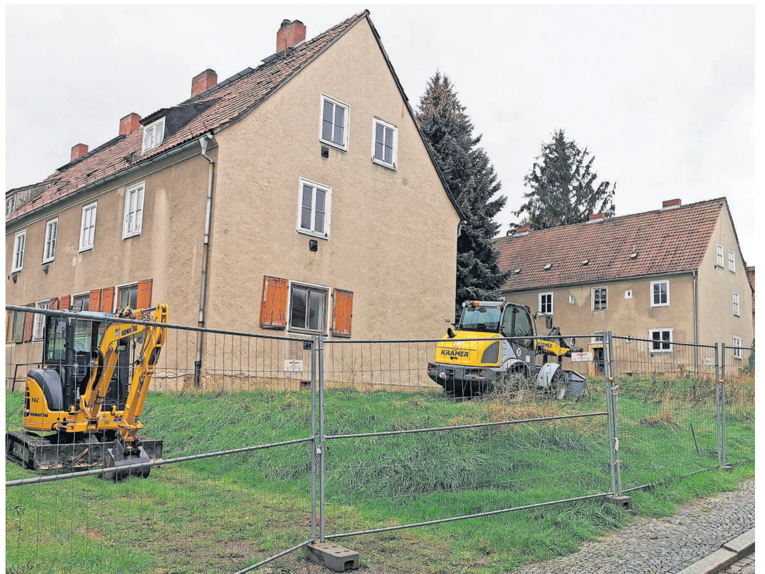
Schilder, Zaun und schweres Gerät sind untrügliche Zeichen, dass der Leipziger Bauträger ASE Real Estate ernst gemacht und mit der Sanierung des Großteils der früheren Gagfah-Siedlung in der Altenburger Südstraße begonnen hat.
