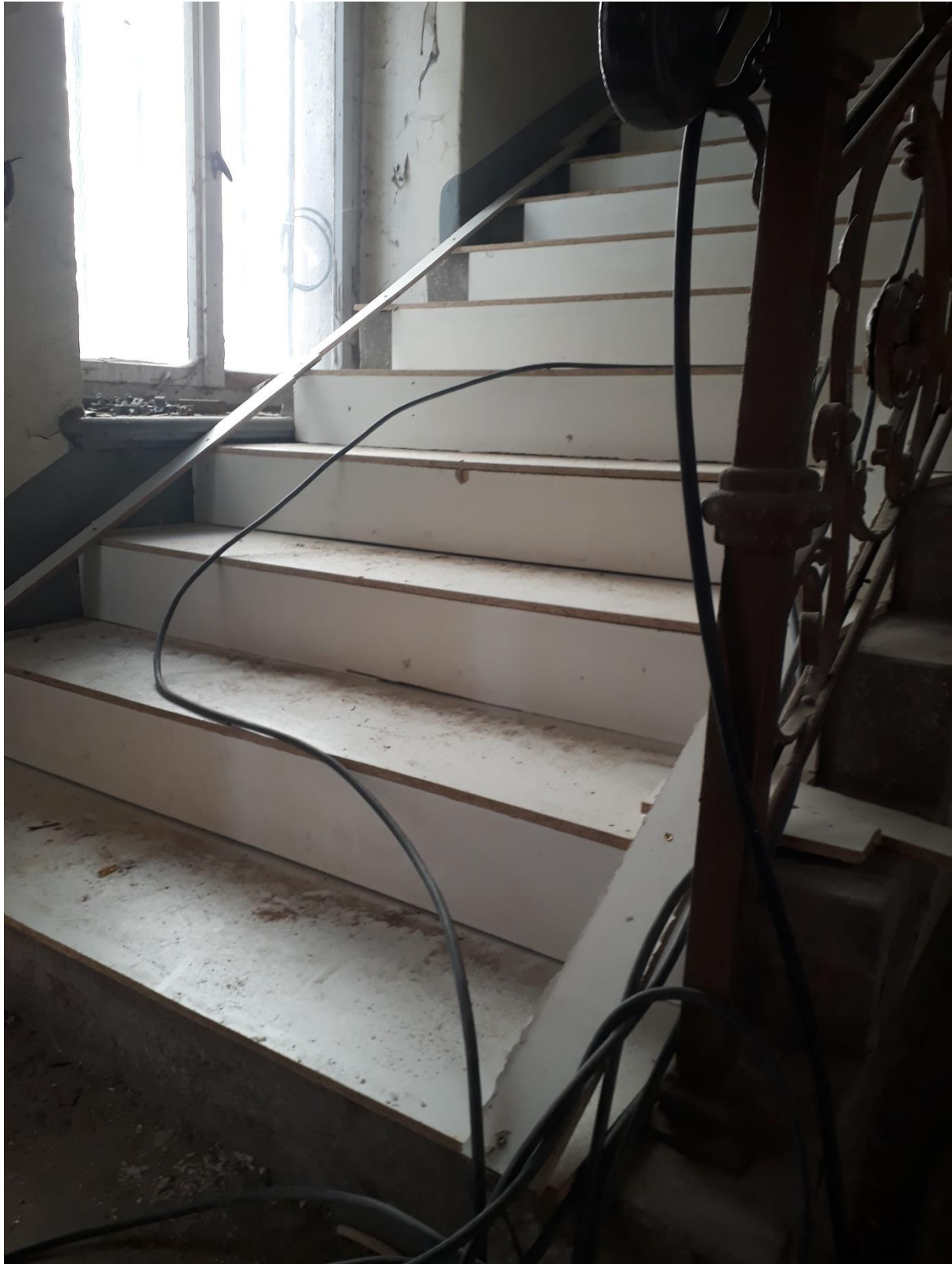
Schutzmaßnahmen für das Bestandstreppehaus
