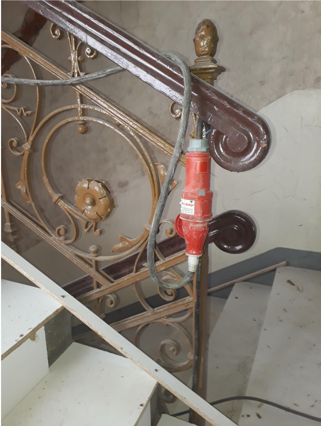
Schutzmaßnahmen für das Bestandstrepfenhaus
