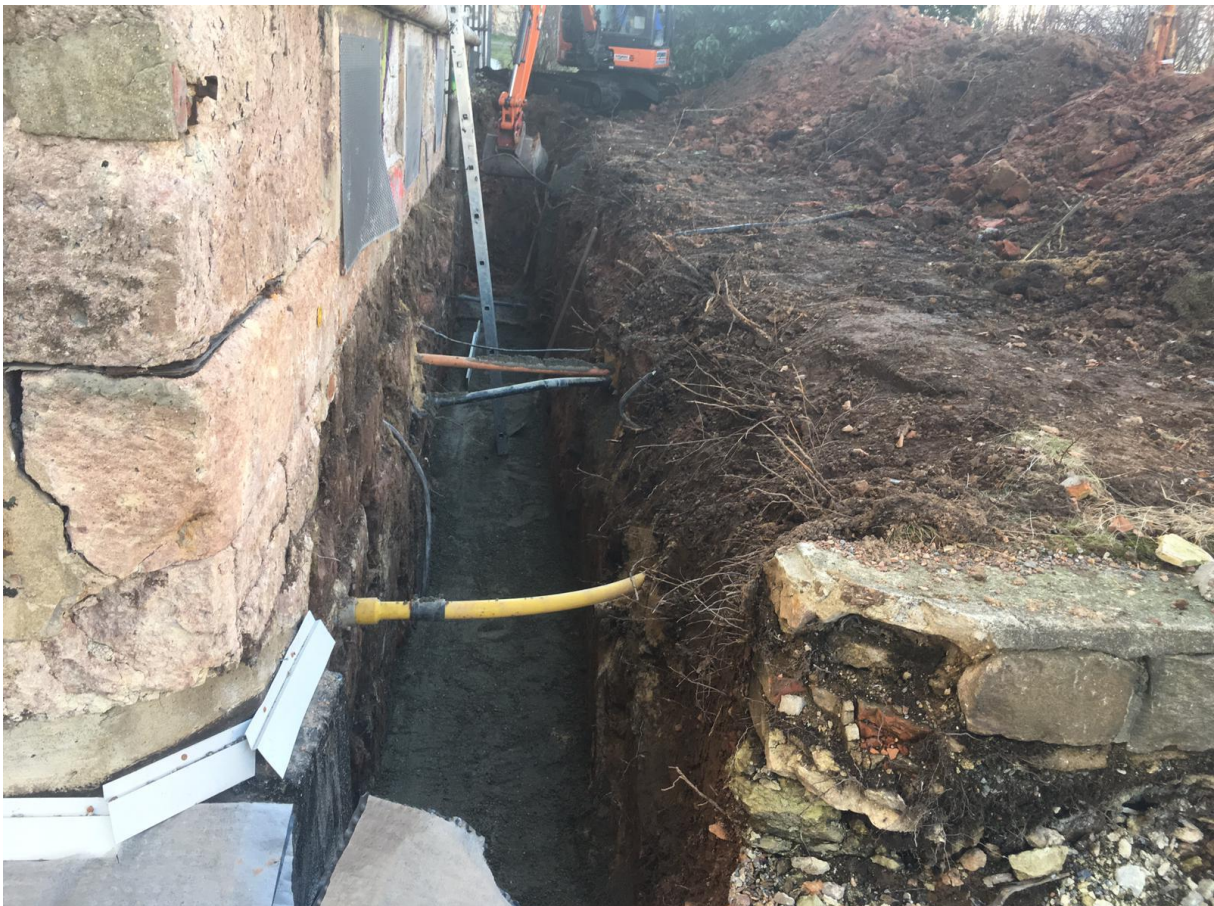
Vorbereitungen zur Bauwerkabdichtung / Schachtarbeiten
