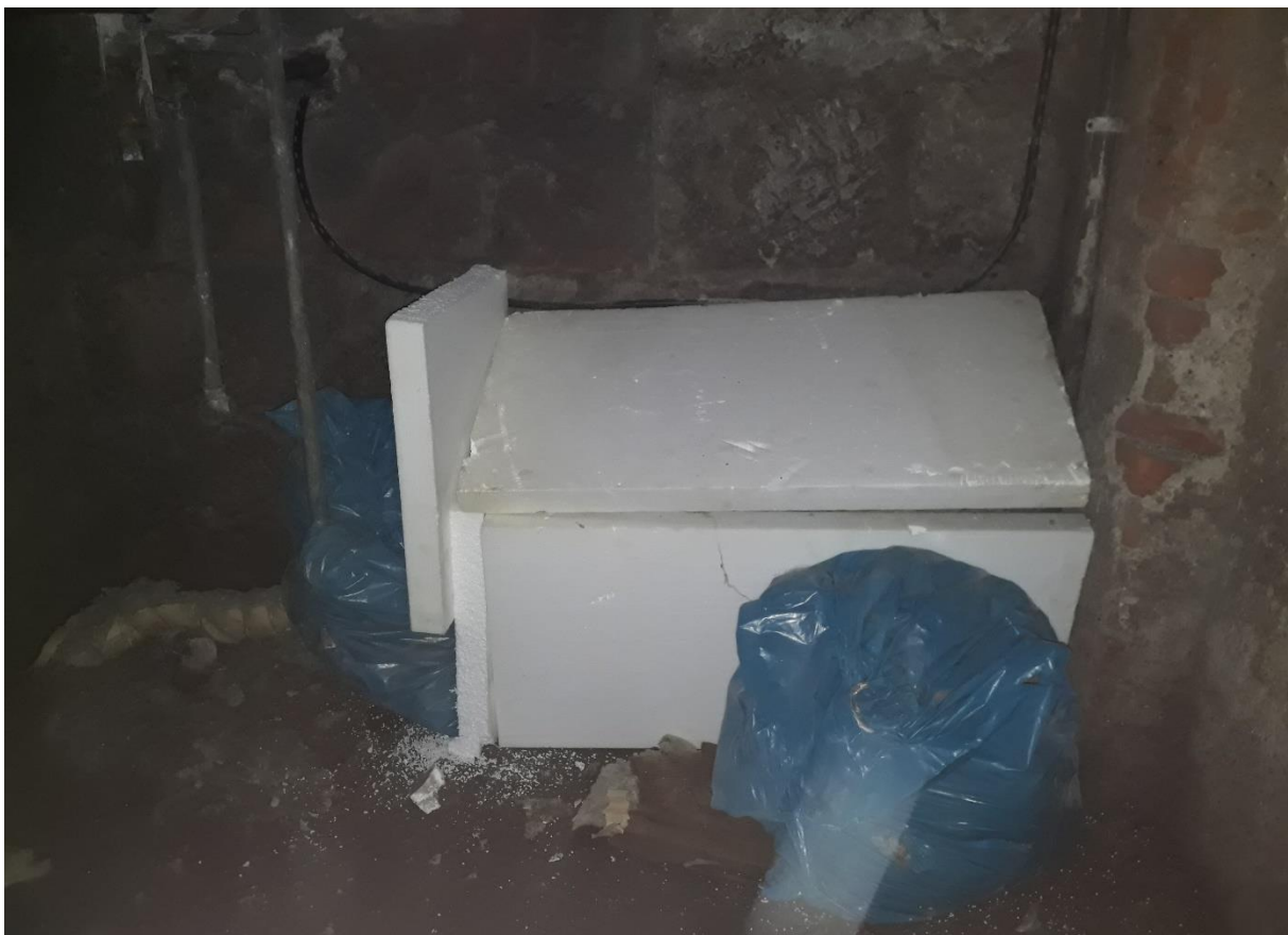
Wiederinbetriebnahme der Wasserversorgung / Frostschutzmaßnahmen an der Wasseruhr
