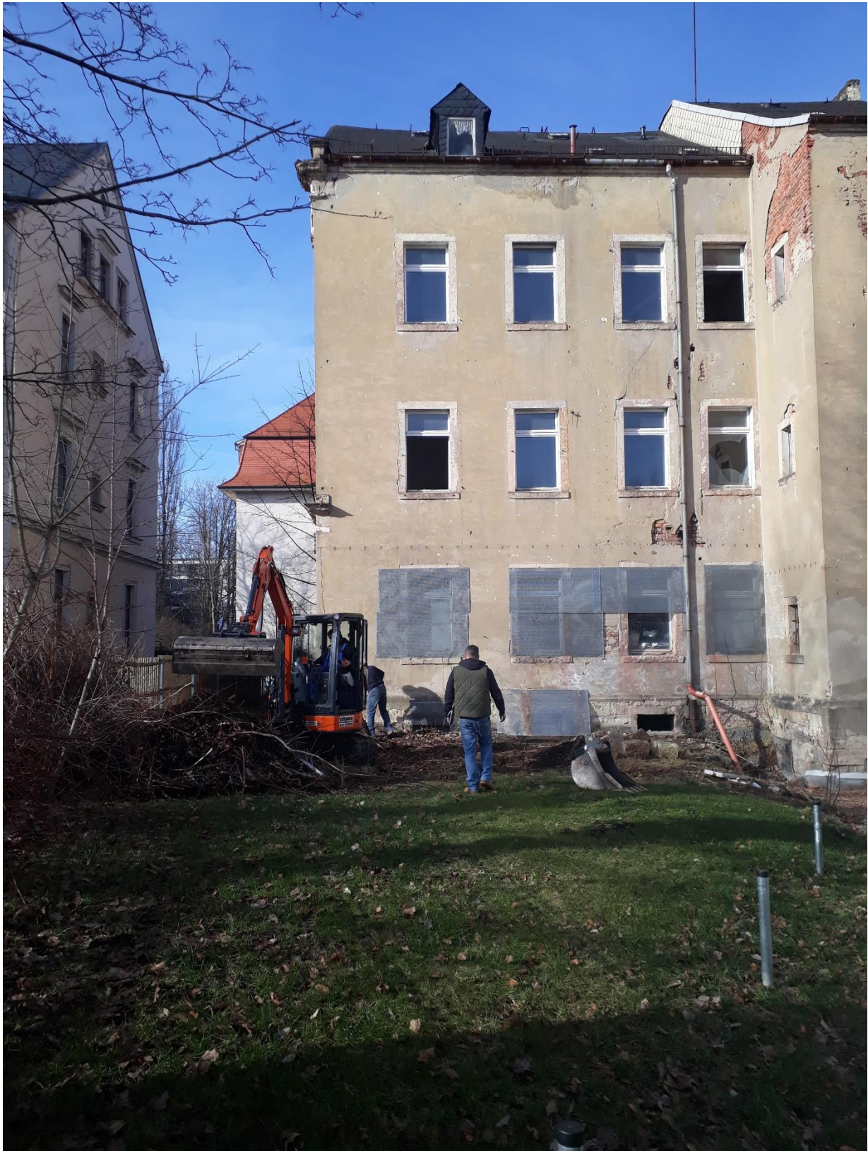
Beräumung von Schutt und Sondermüll
