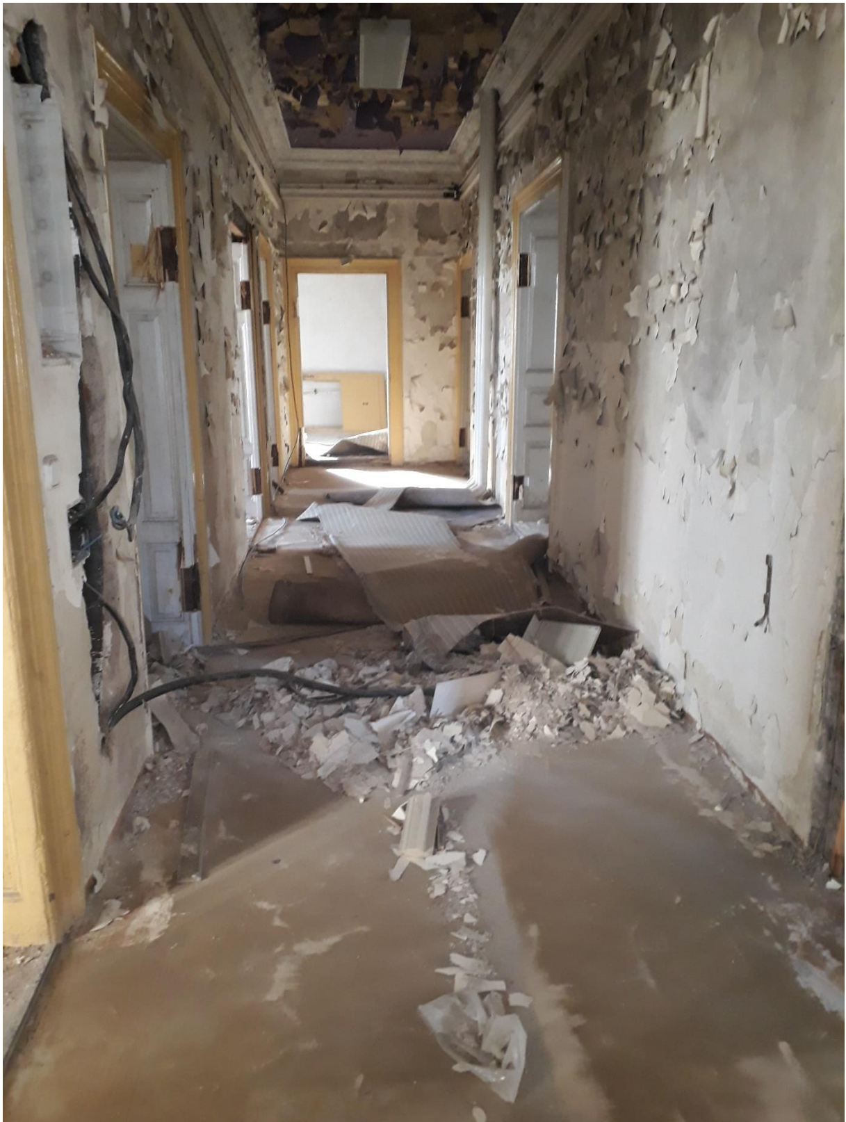
Abbrucharbeiten in den einzelnen Geschossen
