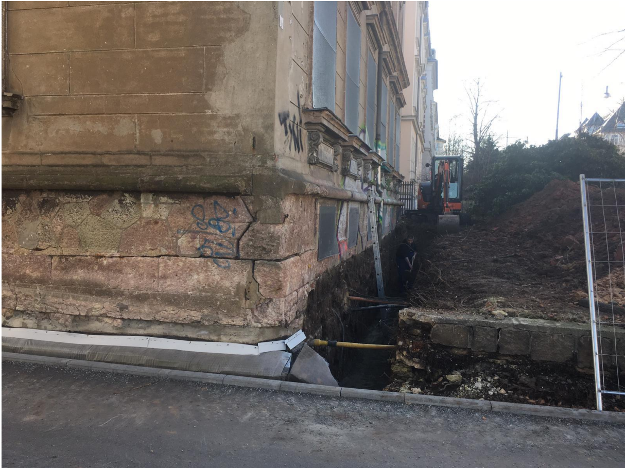
Vorbereitungen zur Bauwerkabdichtung / Schachtarbeiten
