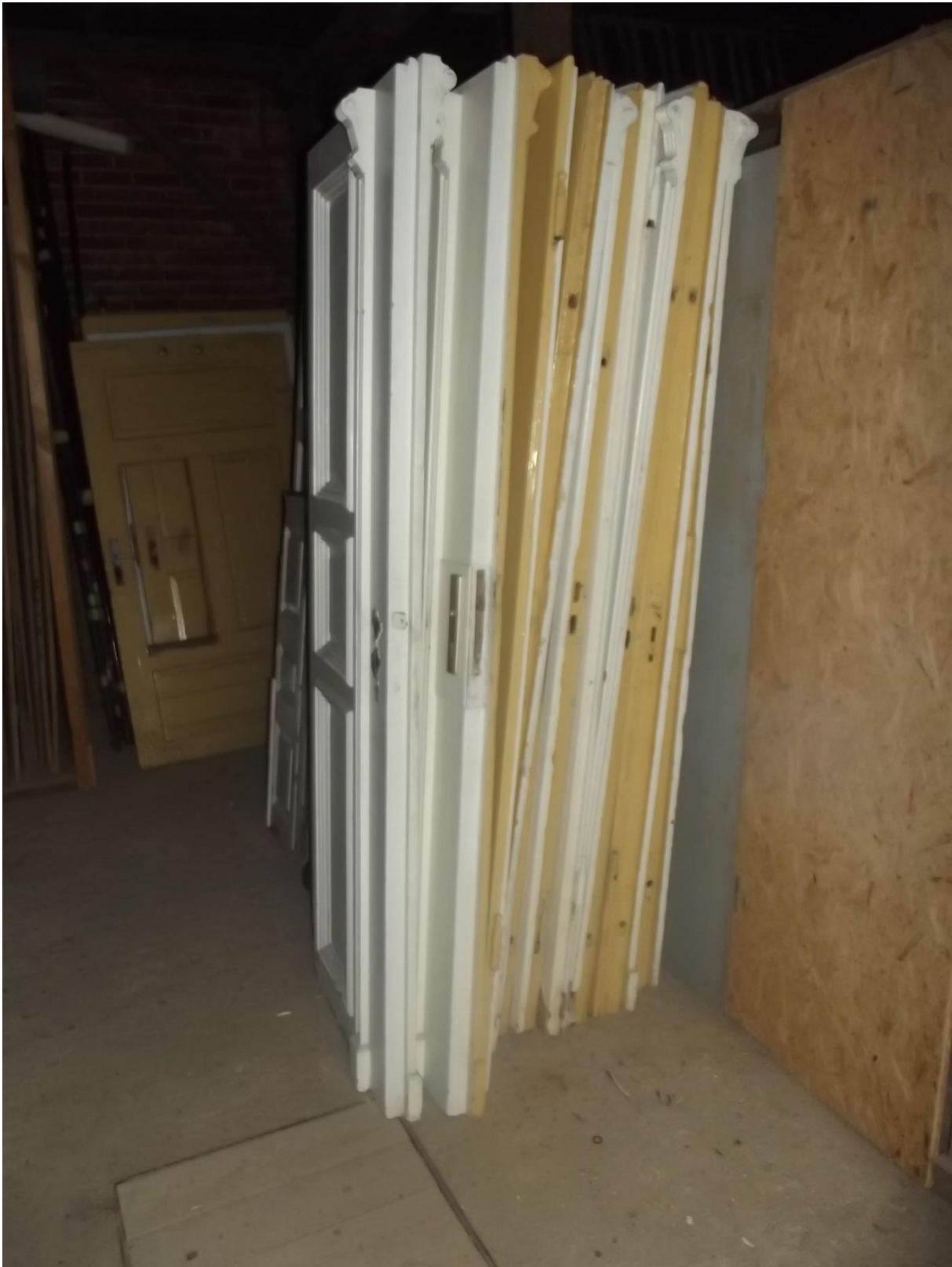
Zerstörungsfreier Ausbau der zweiflügeligen Wohnungs- und Innentüren sowie Zargen
