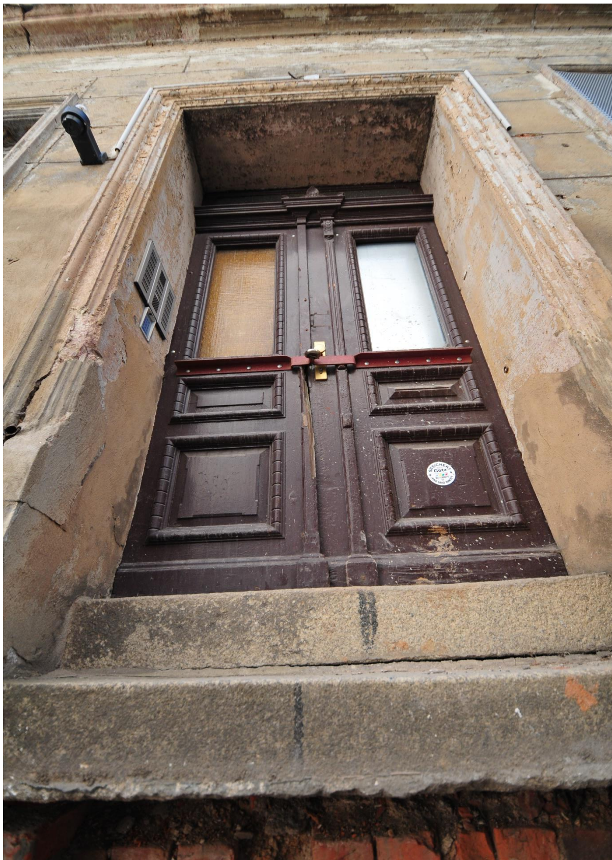
Historischer Treppenhauszugang / Eingangsbereich
