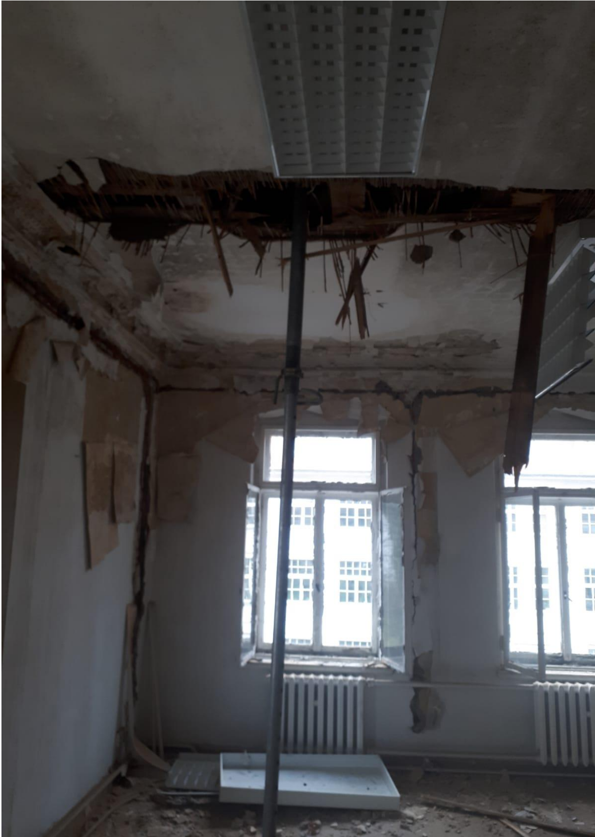
Sicherung der Geschossdecken vor dem Einstürzen
