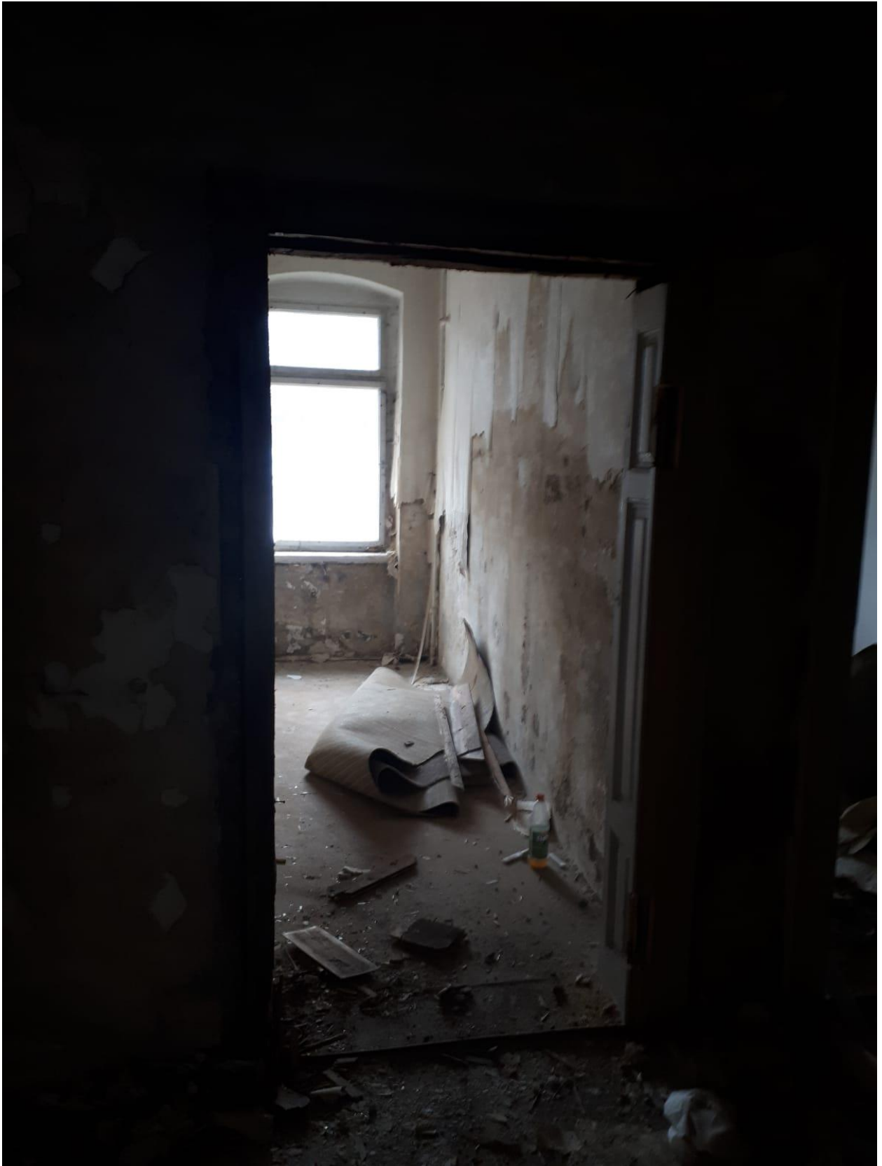
Ausbau und Einlagerung der ersten Innentüren zu Restaurationszwecken
