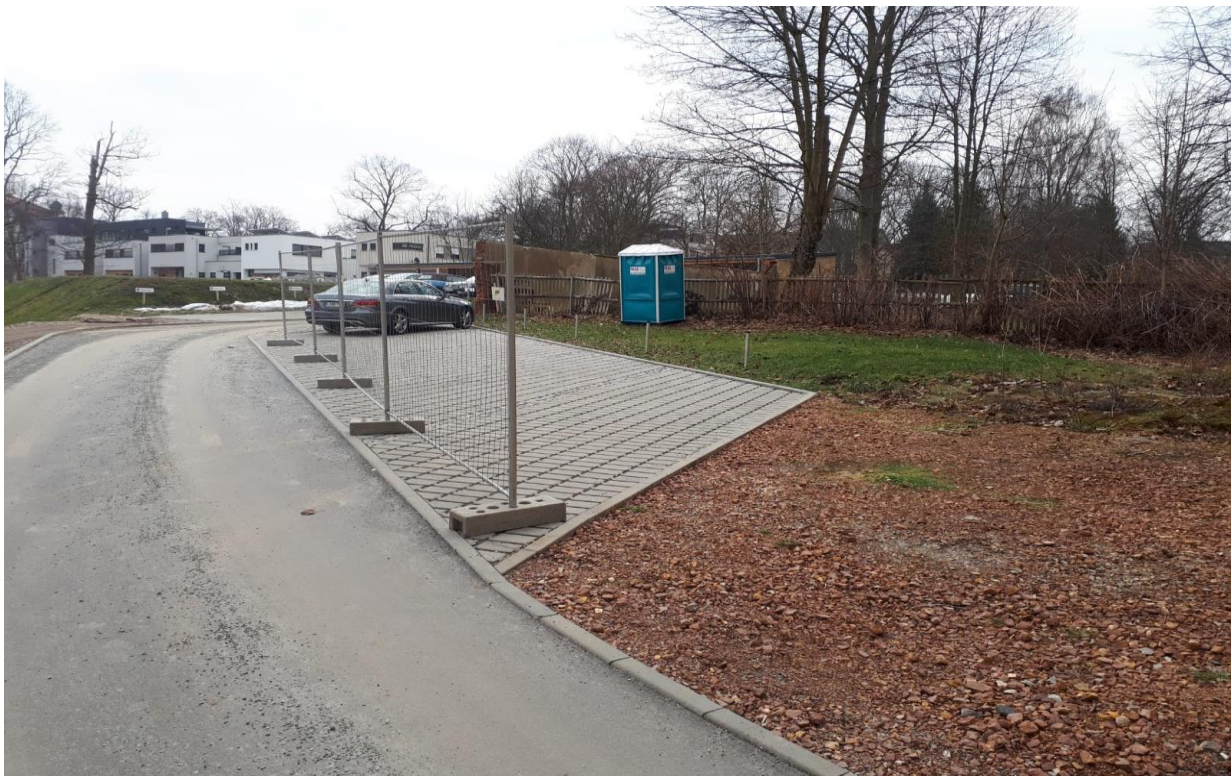
Baustelleneinrichtung an der Rückseite des Gebäudes entlang der Stellplätze
