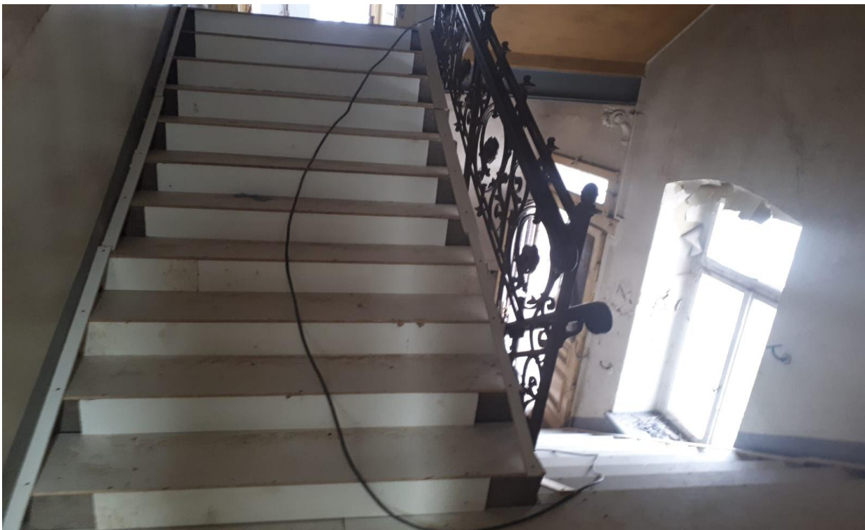
Baustromversorgung im Treppenhaus zwischen EG und 1. OG
