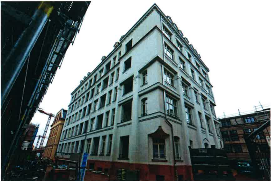
In den sogenannten Königsbau der Gohliser Bleichertwerke sind gerade die ersten Nutzer eingezogen. 42 Wohnungen und einen Fitness-Bereich zauberte Instone in das 1911 erbaute Haus. Quelle: André Kempner
