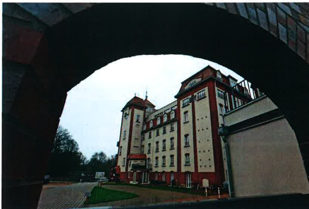
Die früheren Mühlenwerke in Stahmeln wurden denkmalgerecht saniert. 68 Wohnungen sind in der denkmalgeschützten Anlage entstanden. Jetzt folgen nur noch die Außenanlagen. Quelle: André Kempner
