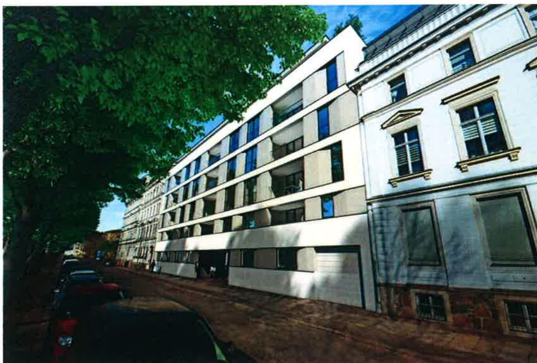
In der Friedrich-Ebert-Straße 112 wird noch in diesem Frühjahr der erste Spatenstich für einen Neubau mit 16 Eigentumswohnungen, Loggien, Tiefgarage und großem grünen Hof gesetzt. Quelle: Homuth + Partner
