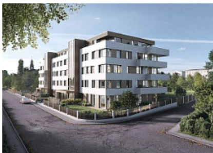
Neues Bauprojekt der ASE Leipzig
