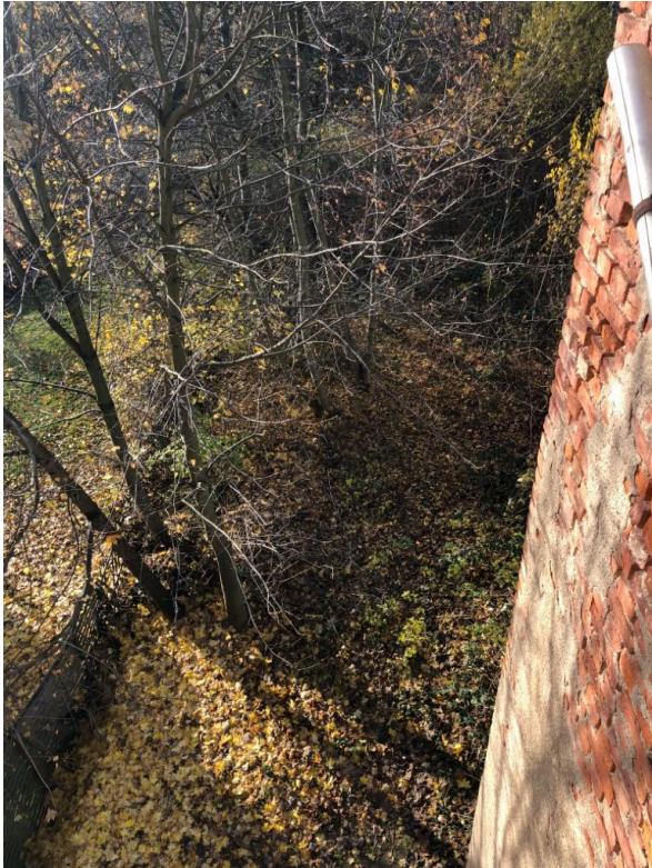
Entfernung von Schutt von der Hofanlage
