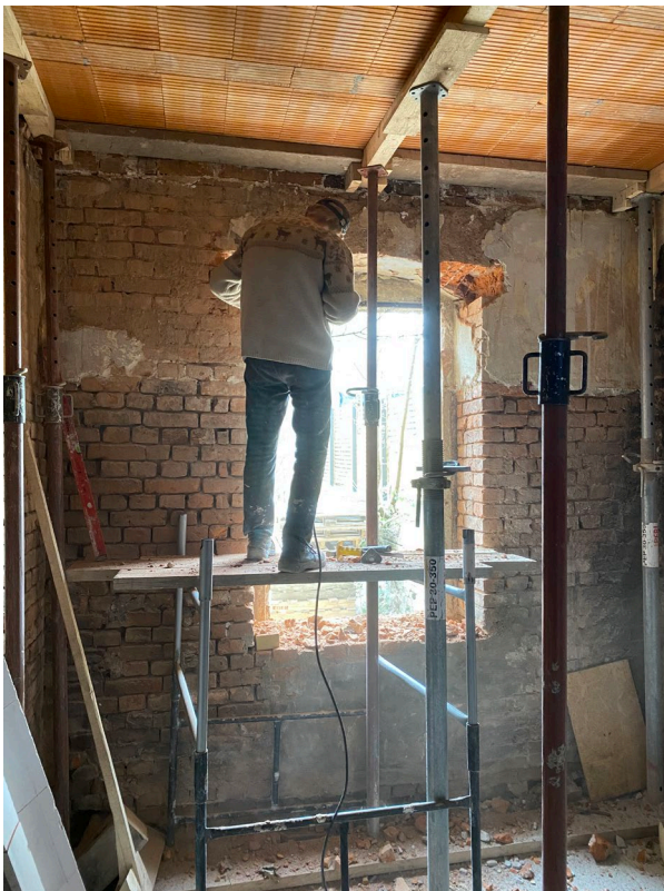
Sicherung der Geschosdecken
