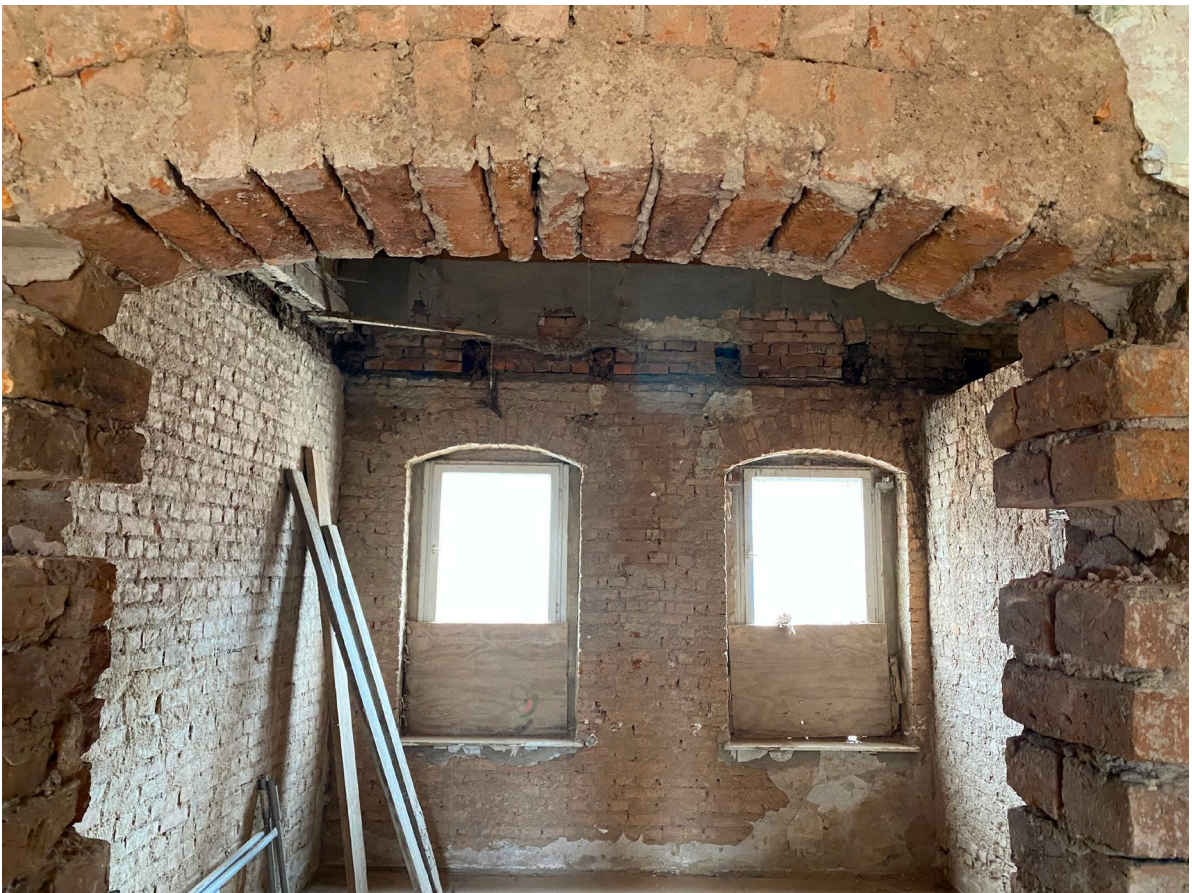
Abrissarbeiten auf allen Etagen
