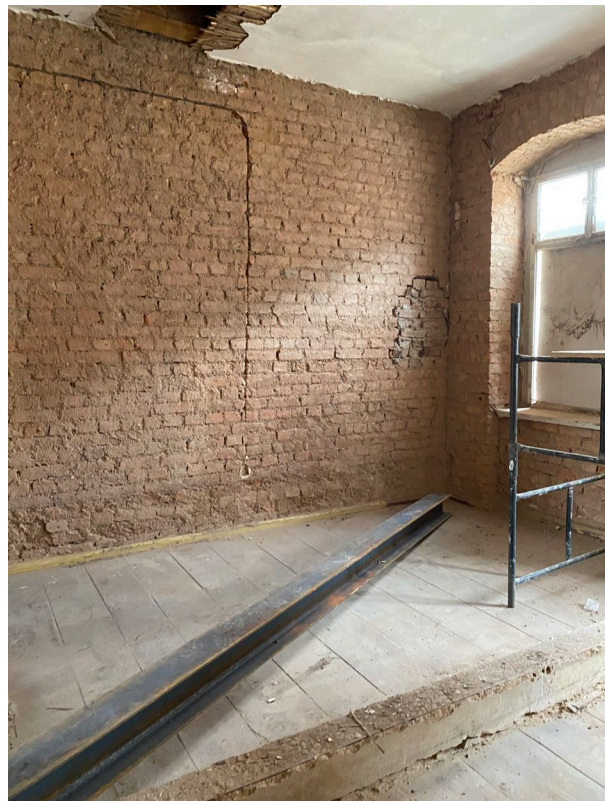
Sicherung der Geschosdecken
