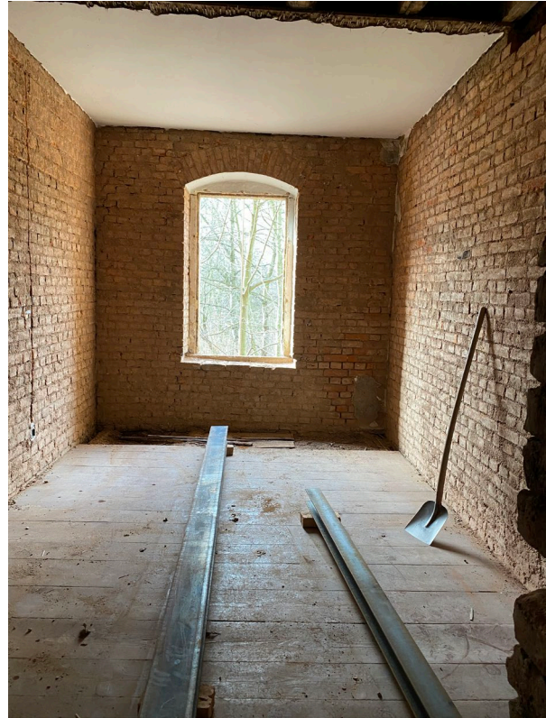
Einbau neuer Stürze sowie spannenunterbrechender Stahlträger
