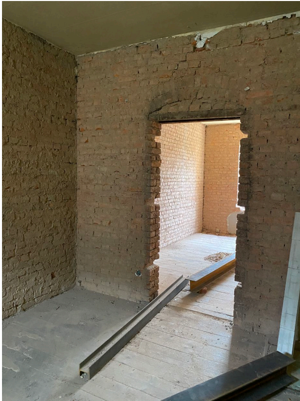
Einbau neuer Stürze sowie spannenunterbrechender Stahlträger
