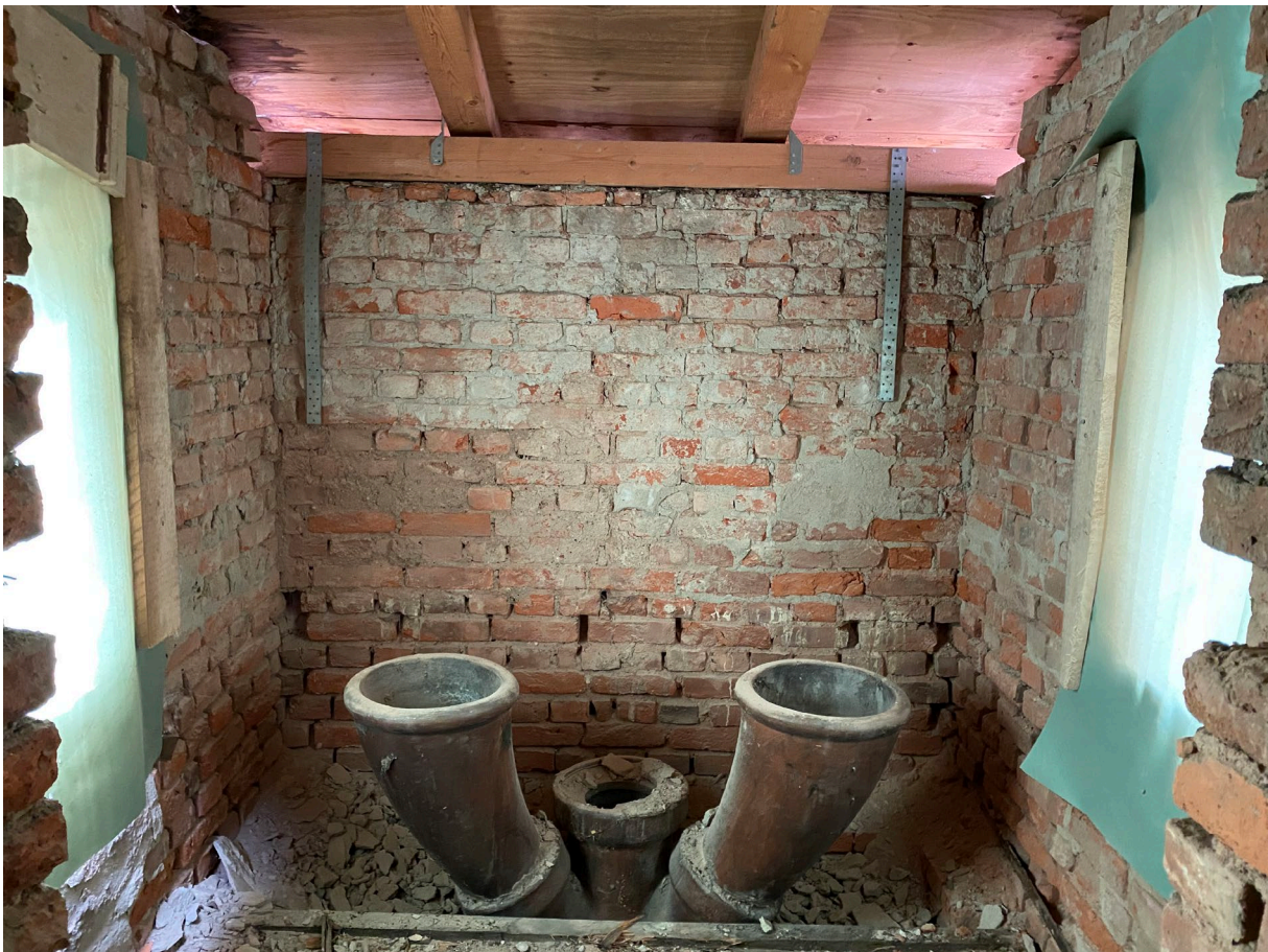
Rückbau der alten Außen-WCs auf halber Etage
