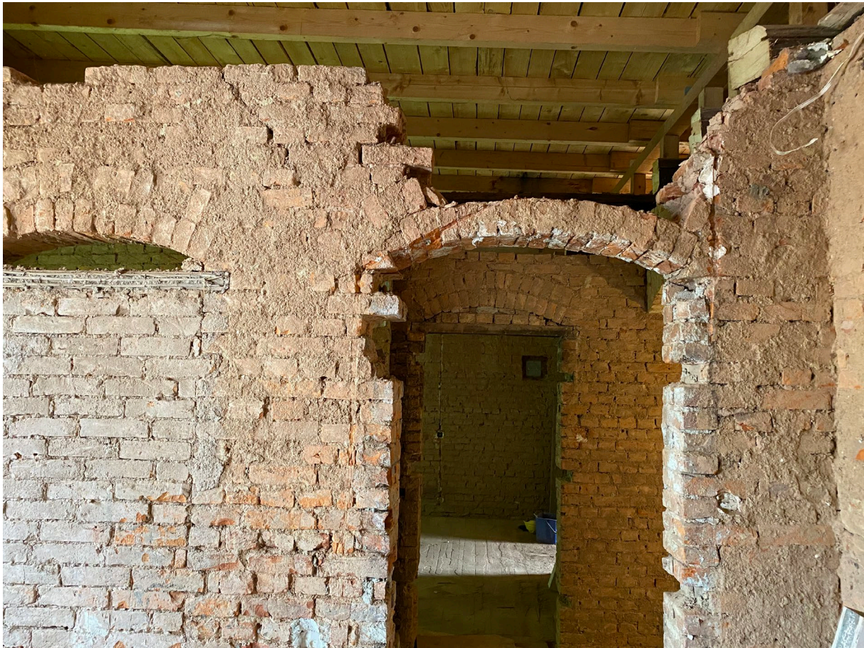
Abrissarbeiten bis unterhalb des Notdaches
