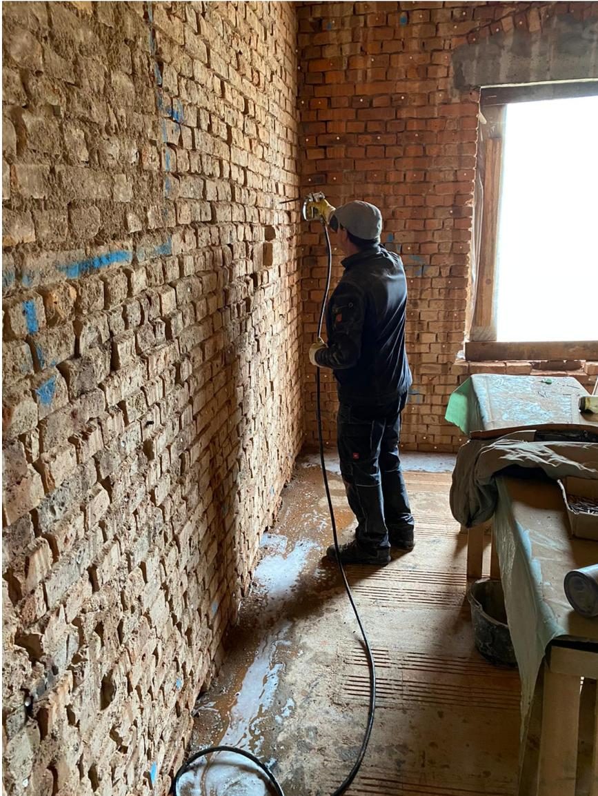
Hausschwammsanierung und Bohrlochdrucktränkung im 2.OG
