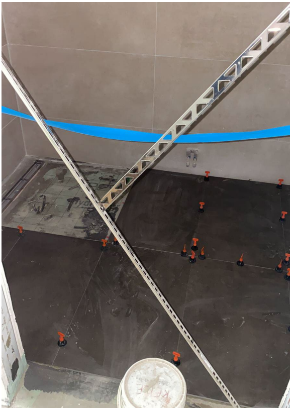
Verlegung der Bodenfliesen in den Bädern
