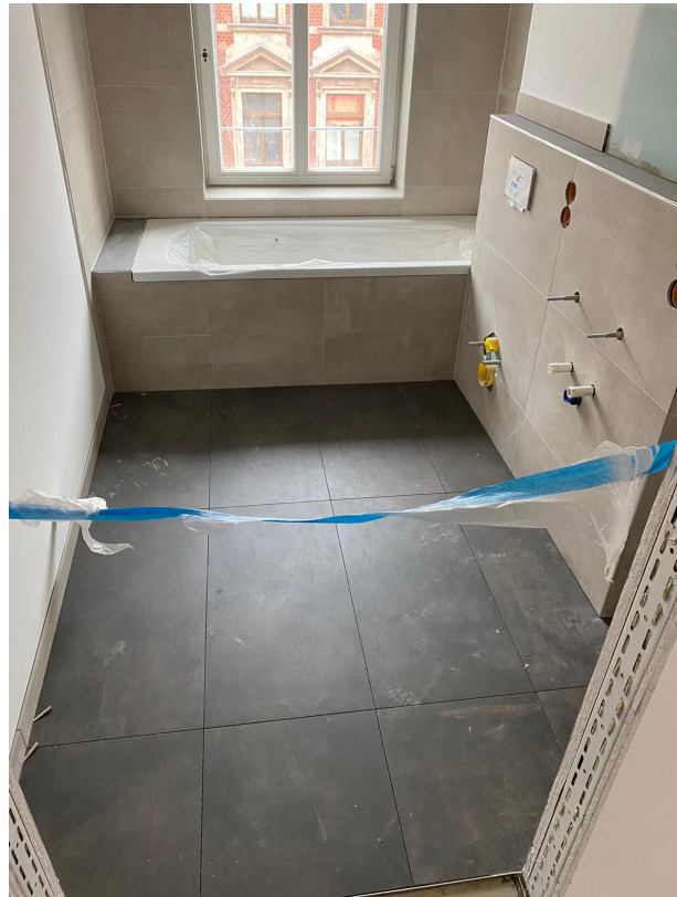
Verlegung der Bodenfliesen in den Bädern
