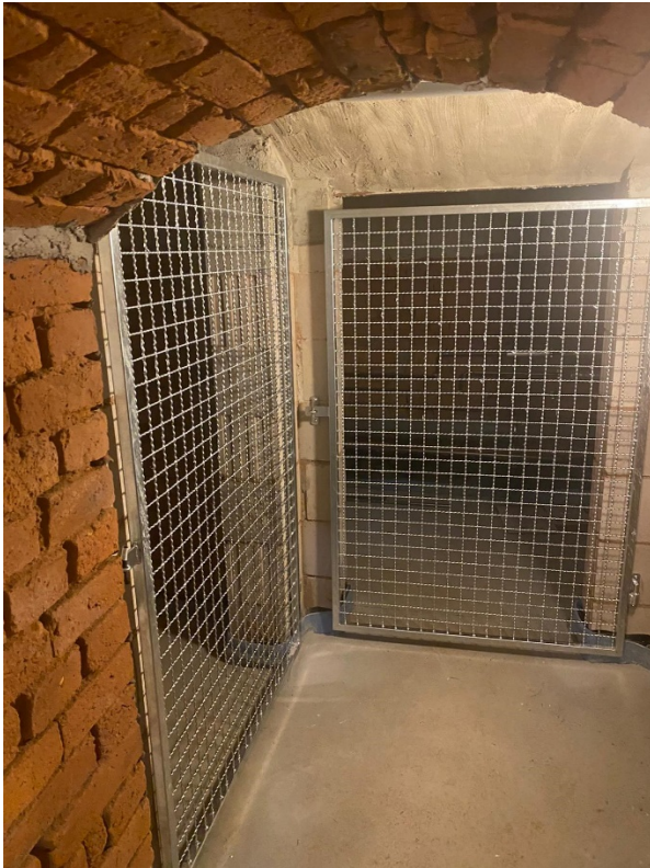
Türen für die Kellerabtrennung wurden eingebaut
