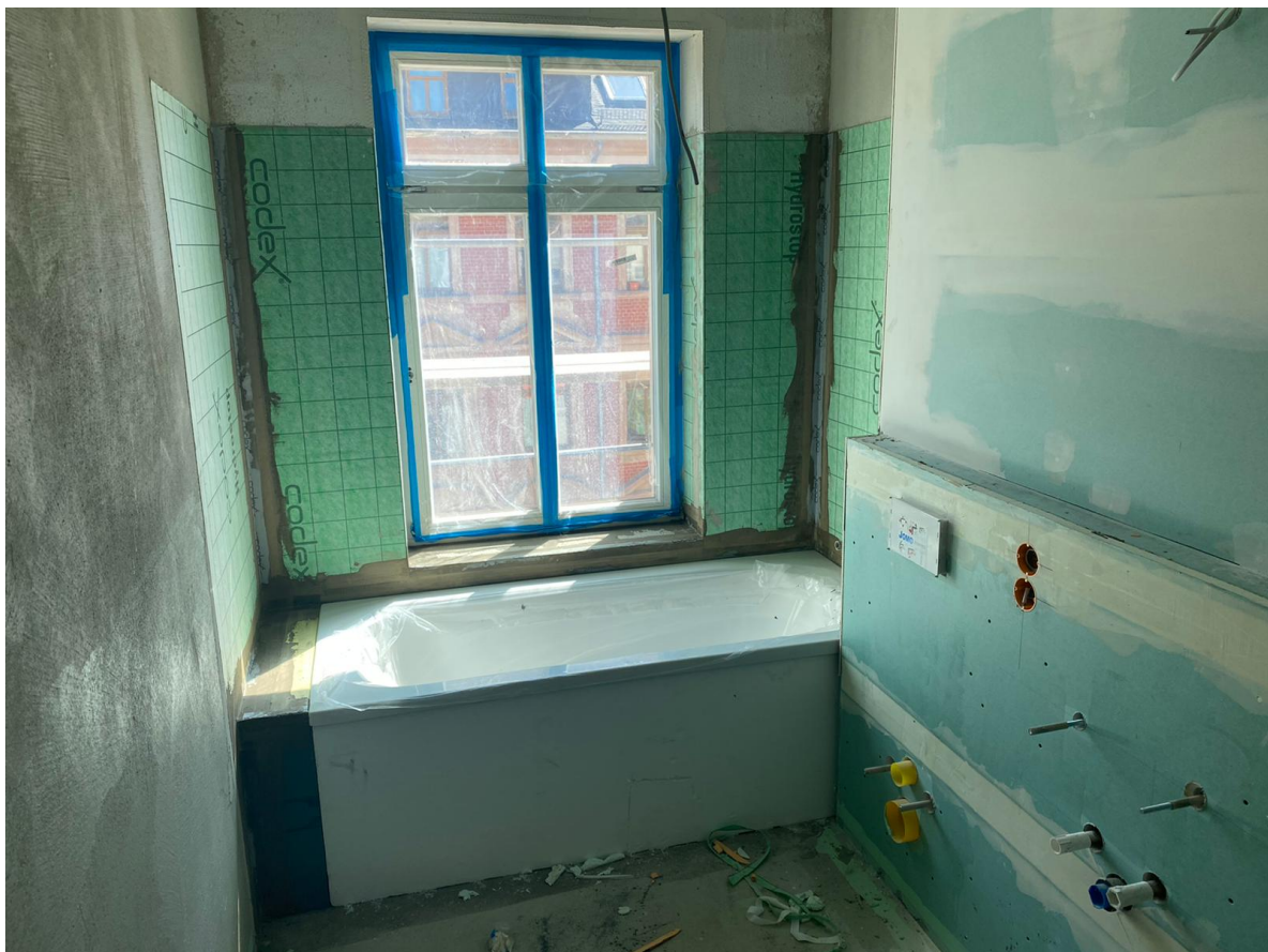
Einbau der Badewannen in den Bädern
