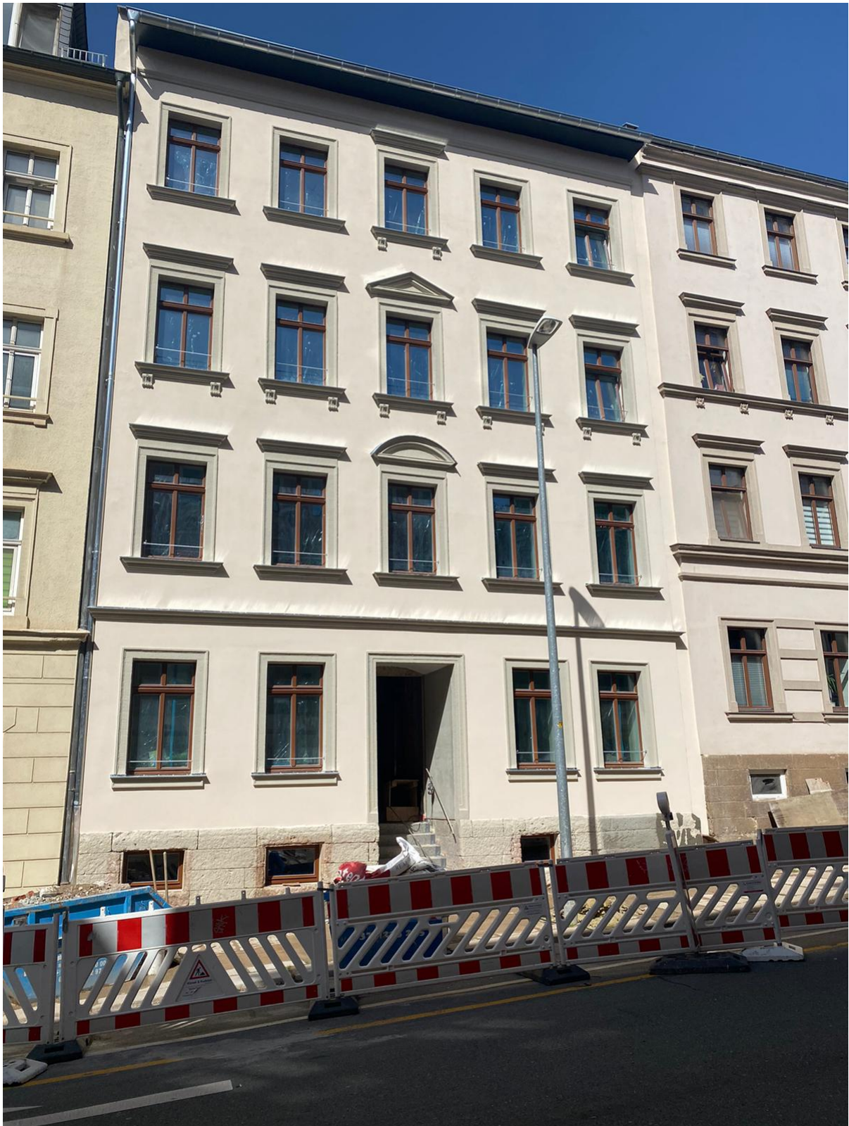
Einbau aller Fenster im Objekt Bergstraße 23
