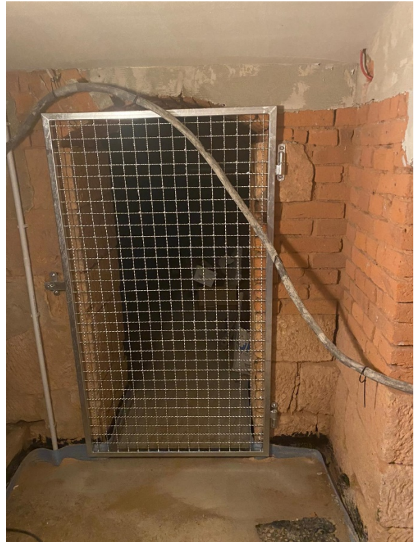
Türen für die Kellerabtrennung wurden eingebaut
