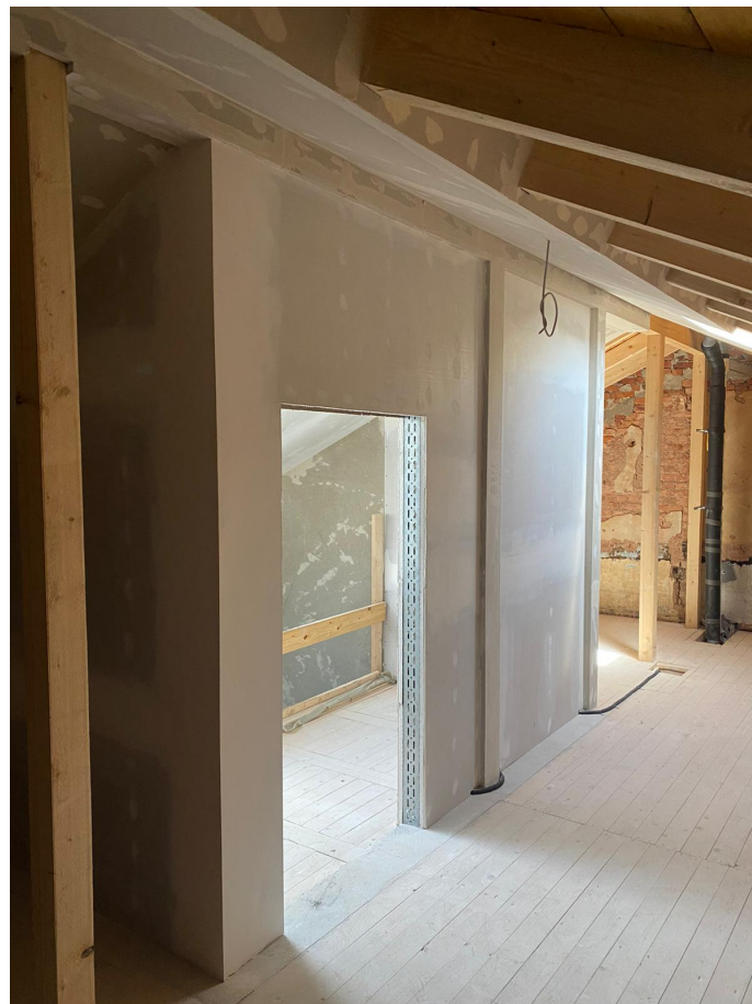
Fertigstellung Trockenbau am Treppenhauskopf
