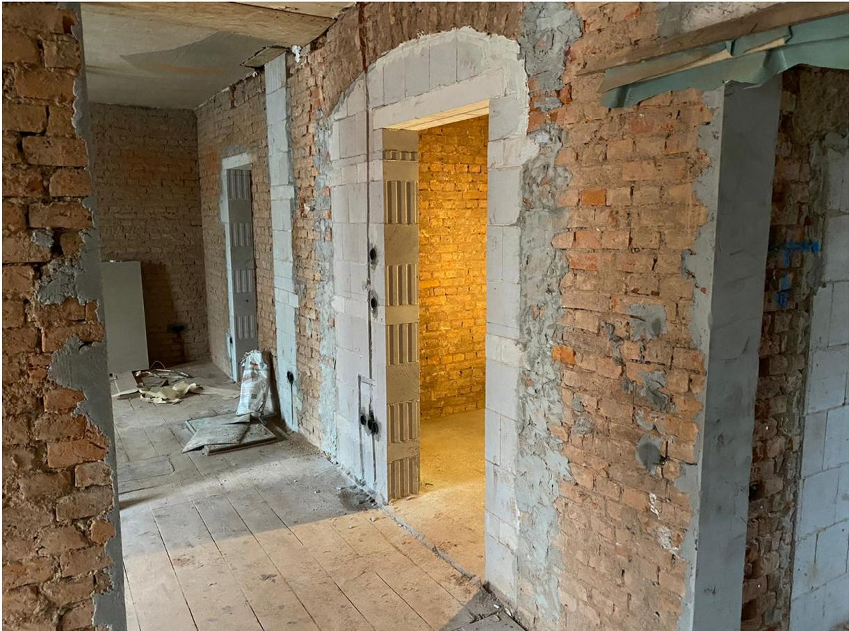
**Rohinstallation Elektro - Stemm- und Schlitzarbeiten**
