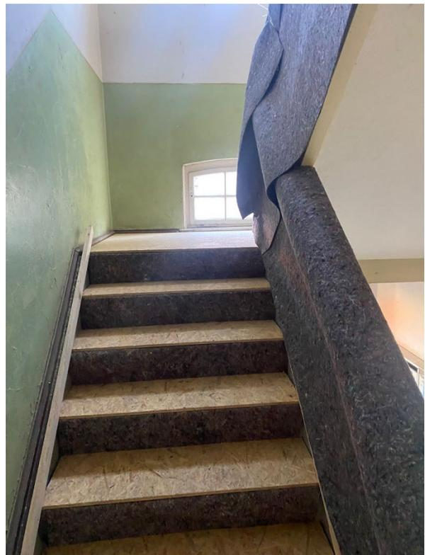
Verkleidung der Treppenhäuser zum Schutz vor Verunreinigung und mechanischer Beschädigung
