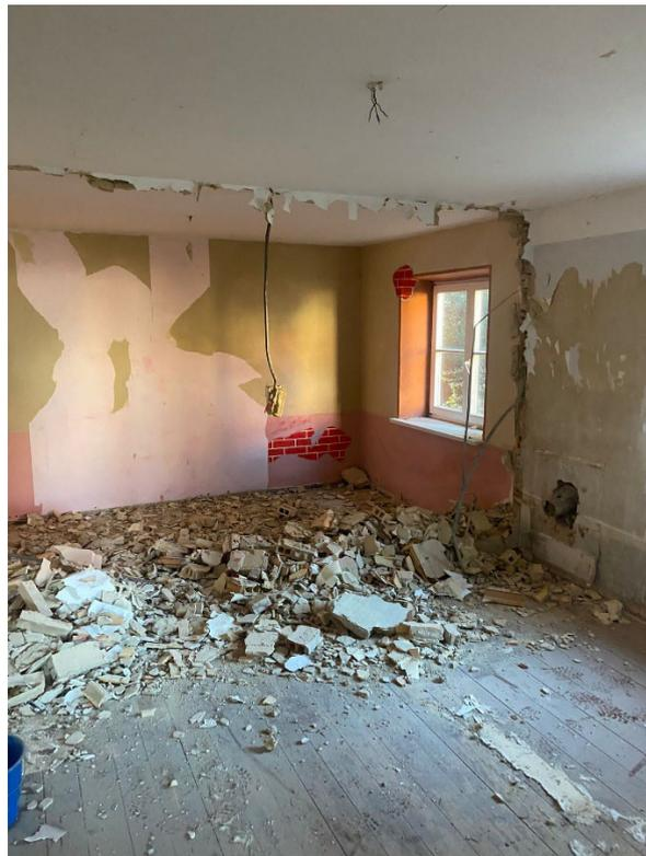
Abbruch der Wände für neue Grundrissgestaltung
