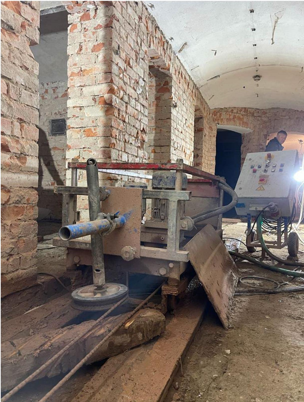
Zwischen- und Außenwände werden mittels Diamantseil horizontal durchtrennt und anschließend mit Kunststoff-Sperrbahnen versehen
