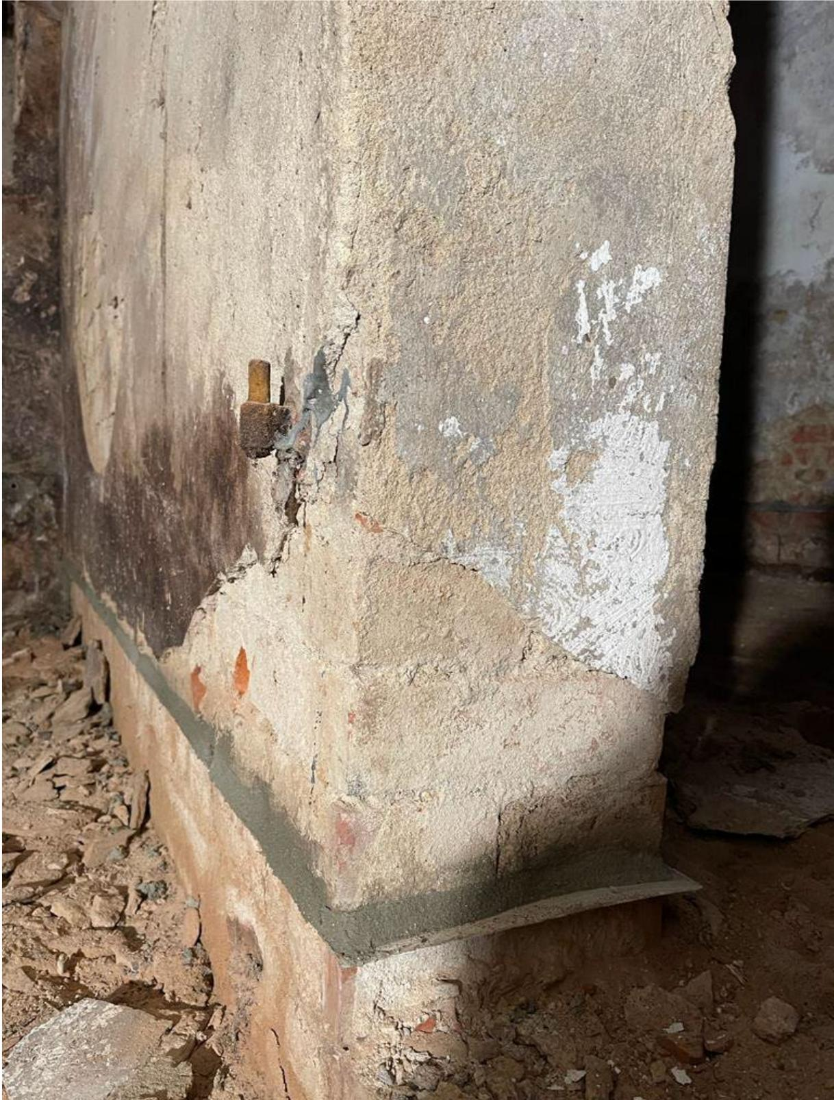
Fertige Wand mit neu hergestellter Horizontalabdichtung und bereits erfolgter Verpressung mit quellfähigem Mörtel
