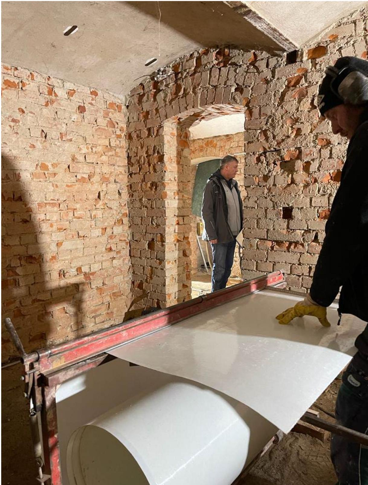
Kunststoffsperrbahnen werden zugeschnitten
