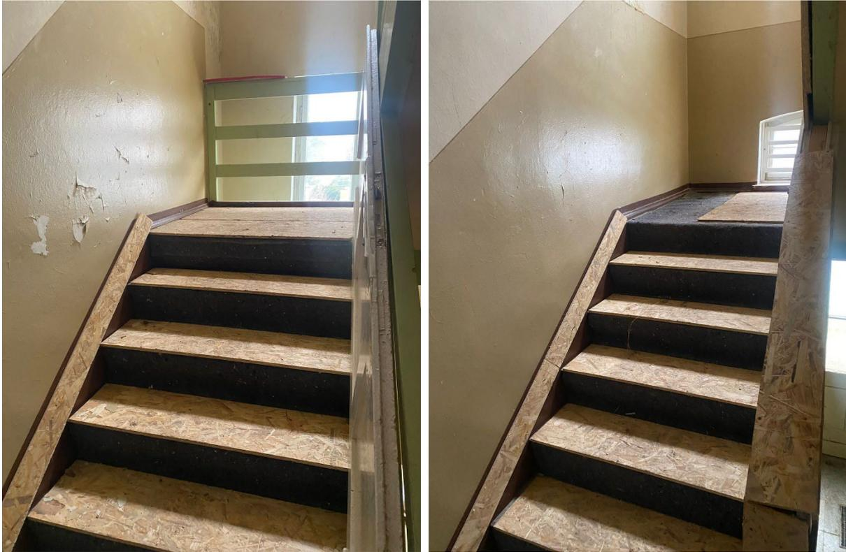
Verkleidung der Treppenhäuser als Schutz vor Verunreinigung und mechanischer Beschädigung
