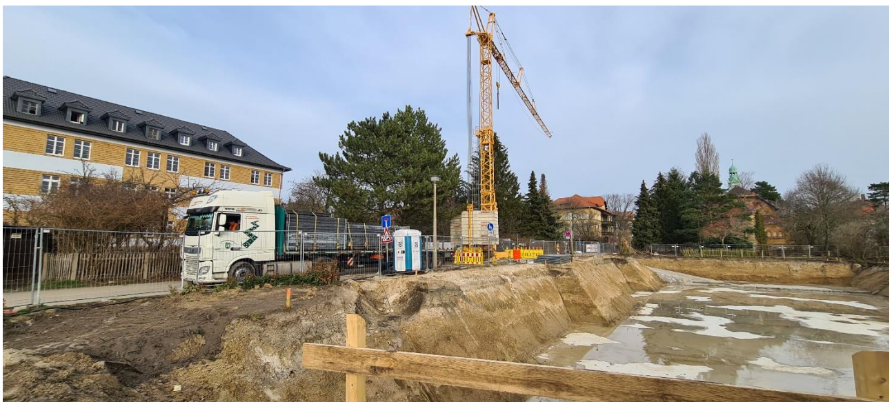
Allgemeiner Überblick über Baustelle
