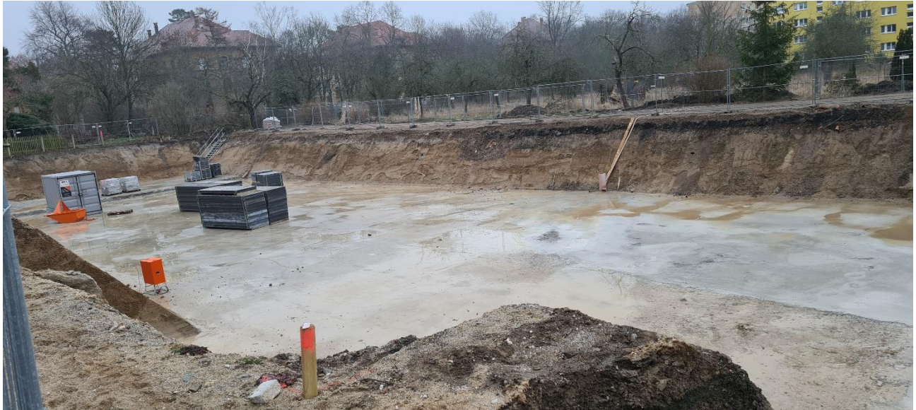
Allgemeiner Überblick über Baustelle
