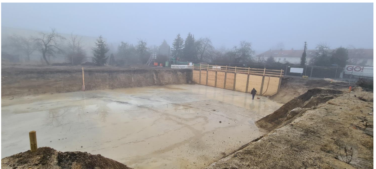
Baugrube mit Verbau und Sauberkeitsschicht
